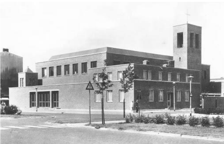
De H.Geestkerk in Vlaardingen, inmiddels afgebroken.
