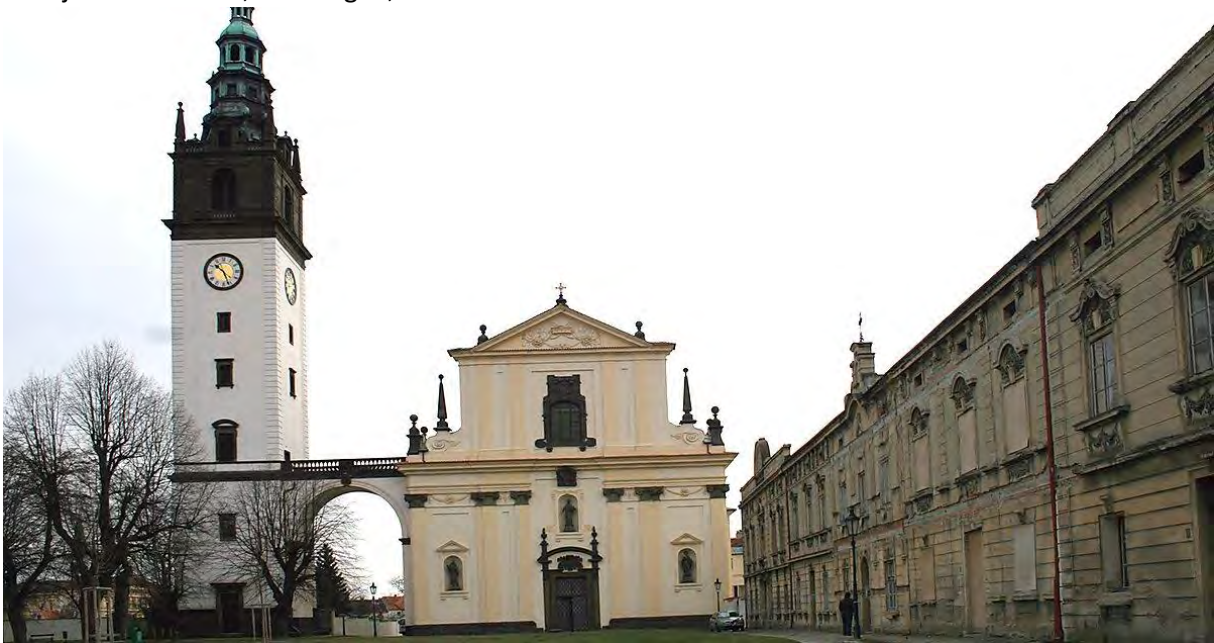
Kathedraal en bisschoppelijk paleis van Litoměřice. De bisschop mocht op de bovenste verdieping twee kamers van dit paleis bewonen. De rest van het gebouw was dichtgetimmerd en vervallen.
